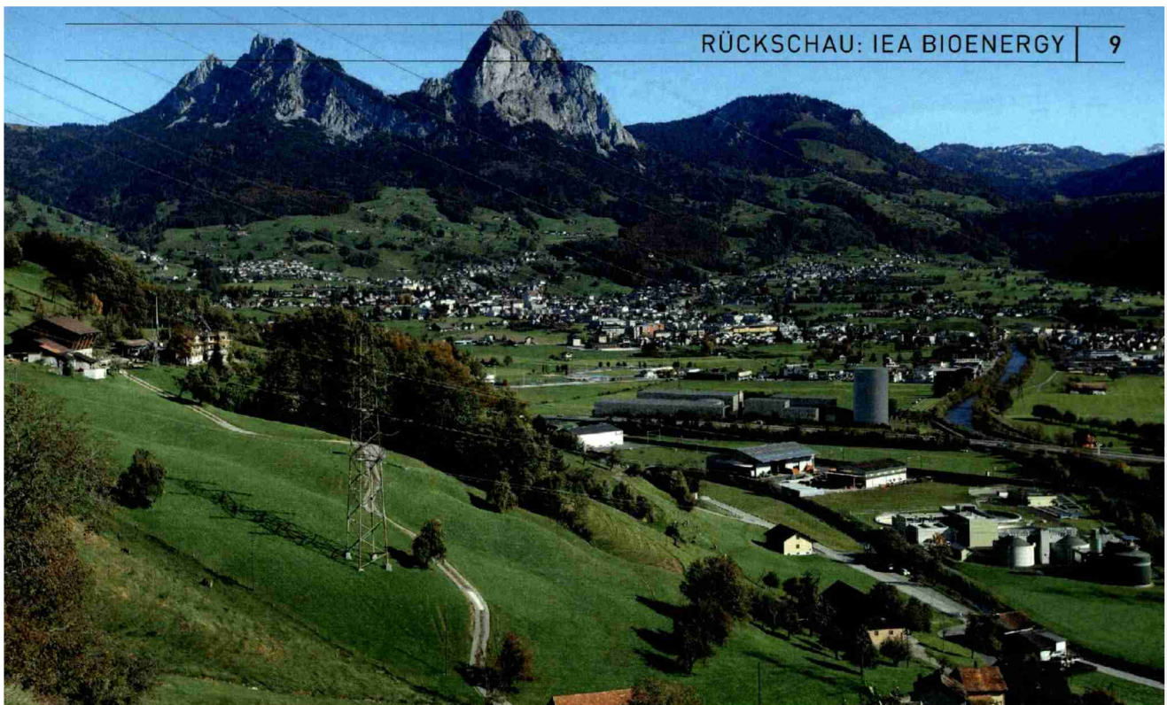
Der geplante Wärmespeicher der Argo Energie Schwyz AG ist 50 m hoch, misst 30 m im Durchmesser und kann bis zu 1300 MWh Wärme speichern.
