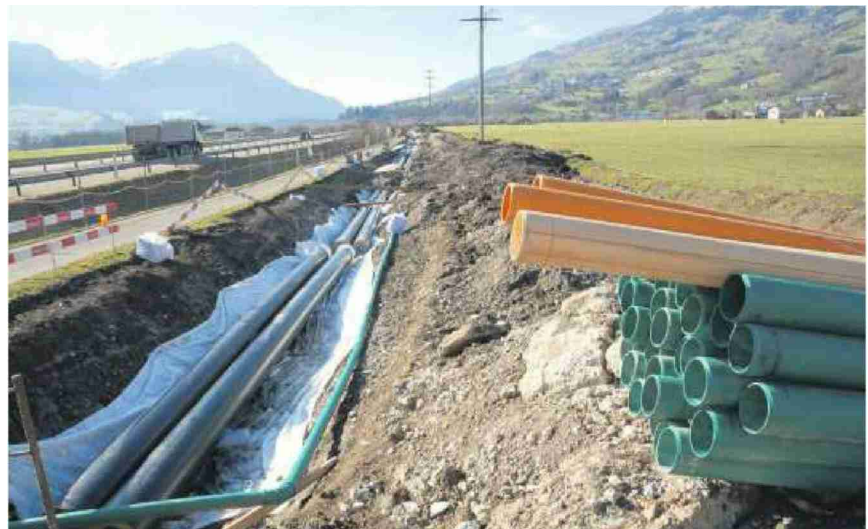
Derzeit ist die fünf Kilometer lange Hauptleitung nach Steinen im Bau, welche ab Herbst das Stauffacherdorf mit Wärmeenergie versorgen wird. Bild: Franz Steinegger
