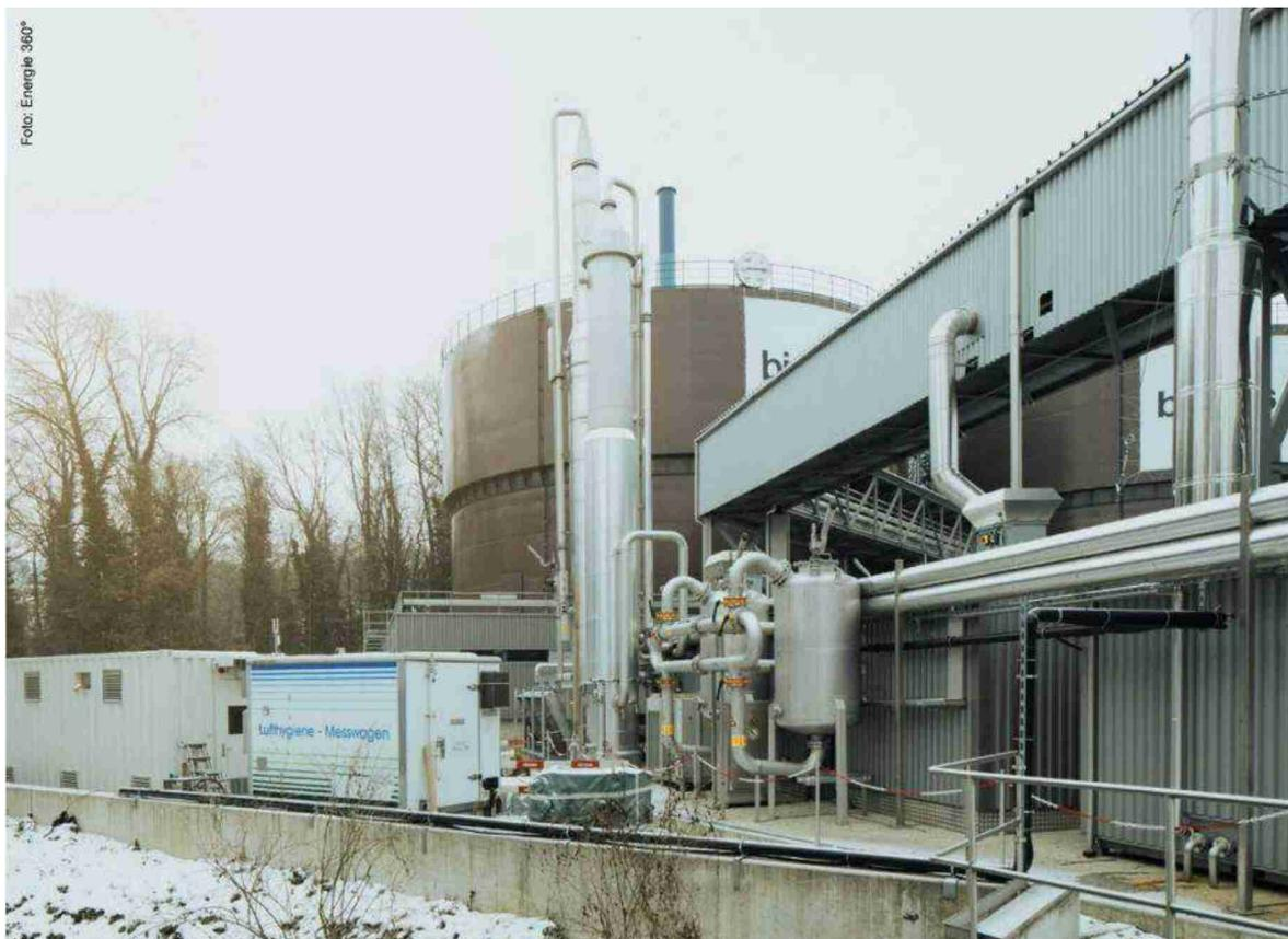
Im ersten Halbjahr 2017 hat die vom Paul Scherrer Institut entwickelte COSYMA-Anlage (untergebracht in dem weissen Container links im Bild) auf dem Areal der Kläranlage Zürich-Werdhölzli bewiesen, dass der Methan-Ertrag aus Rohbiogas durch Zugabe von Wasserstoff um 60% steigern lässt.
