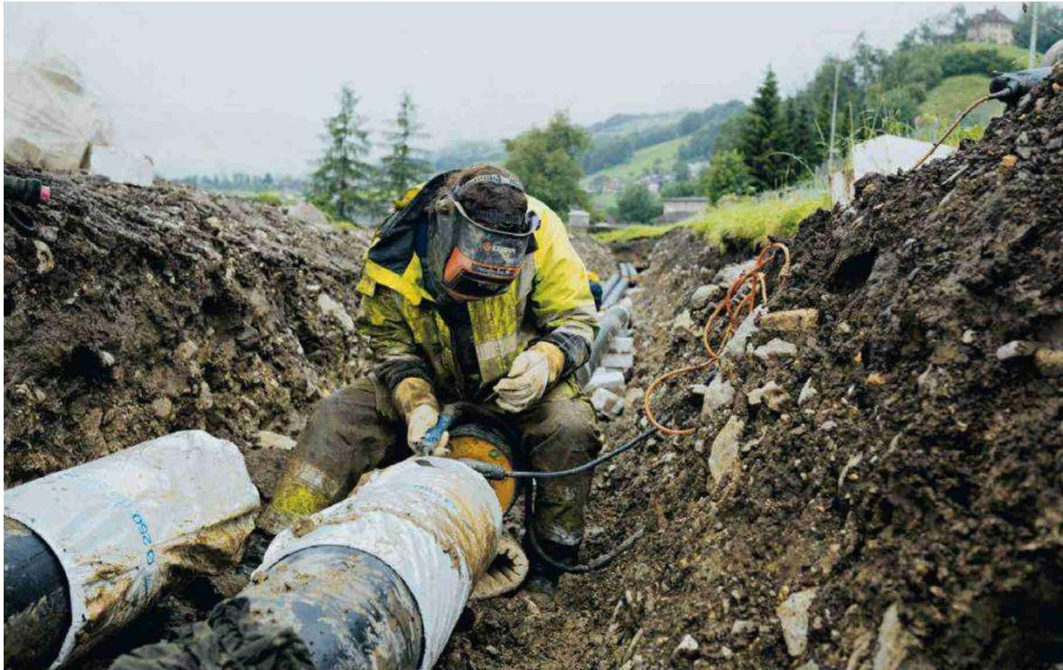
**Fernwärmenetze bedürfen einer guten Isolierung, um Übertragungsverluste bestmöglich zu vermeiden. Das Wärmenetz der Agro Energie Schwyz AG (Bild) verfügt über die beste Isolation (Kategorie III).**
